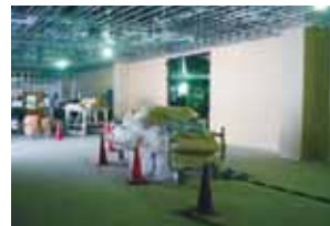
▲内装工事中の工場内部
