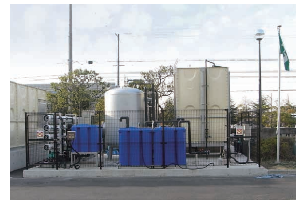
▲地下水膜濾過浄水システム
