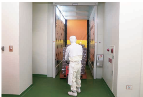
▲荷物用大型エアシャワー
