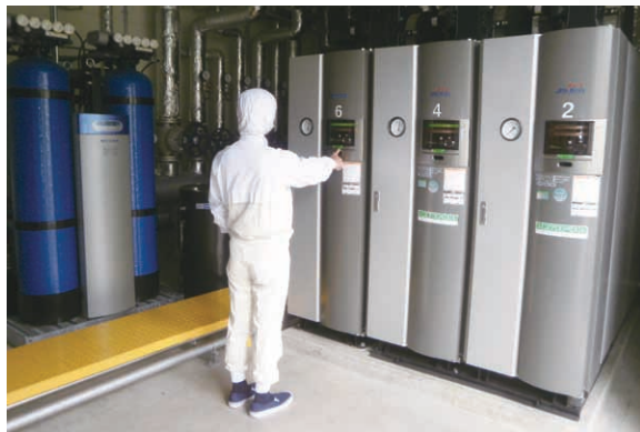
▲都市ガスボイラー
