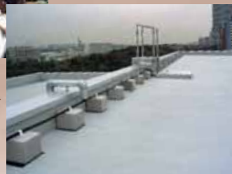
省エネ屋上散水装置▶ 水を流して直射日光による屋根の温度上昇を抑える、六甲アイランドオフィスの省エネ屋上散水装置。
